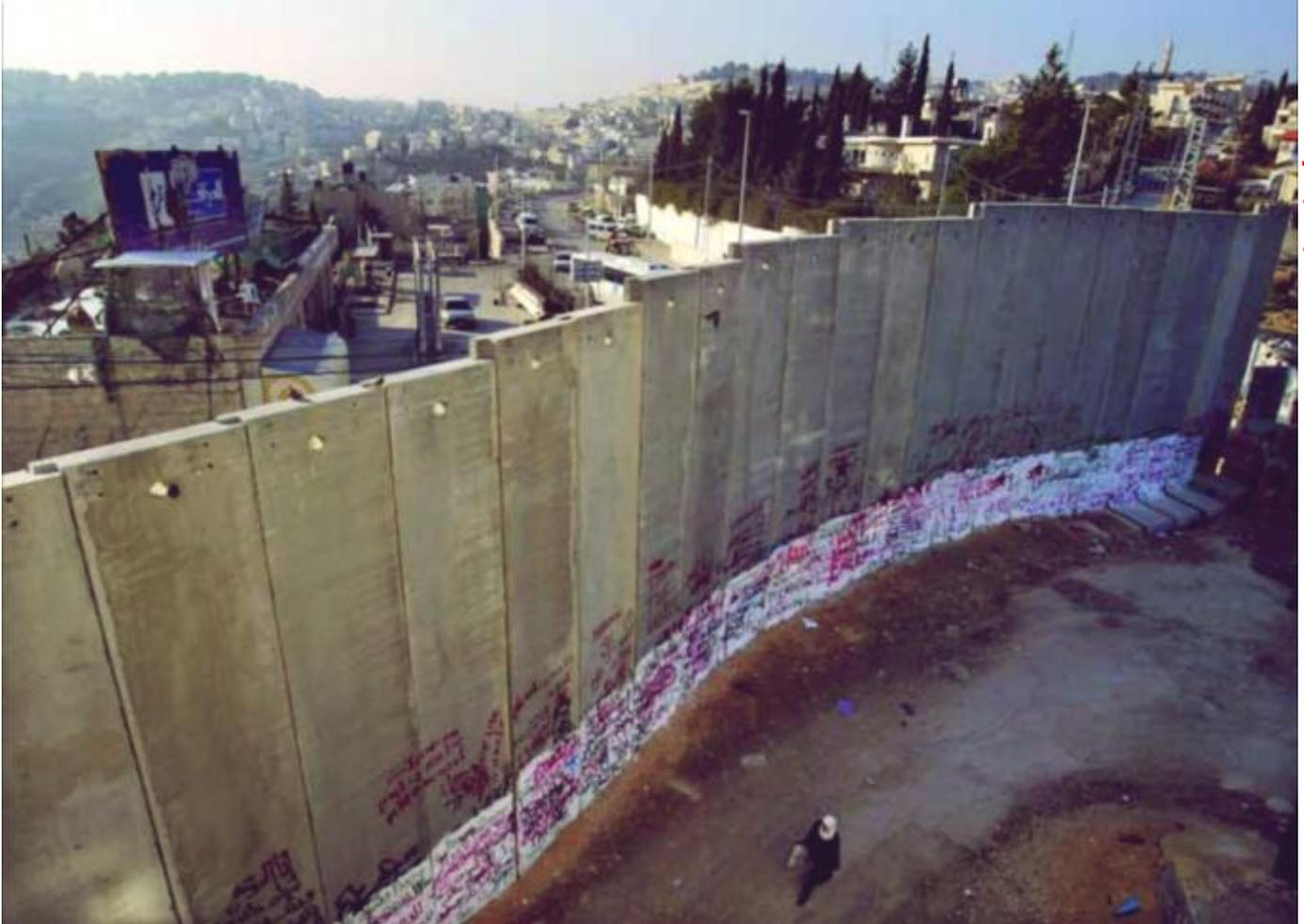
Die Anlage besteht mancherorts aus einer bis zu acht Meter hohen Betonmauer, aus Stacheldrahtzäunen, Gräben, breiten Spurfäden und Panzerpatrouillestrecken sowie aus zusätzlichen Pufferzonen und Sperrstreifen unterschiedlicher Stärke auf beiden Seiten.
