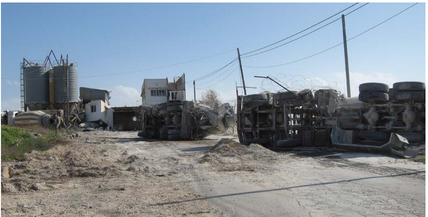
Zerstörte Fahrzeuge und Gebäude der Zementfabrik in al-Zytoun. © Amnesty
